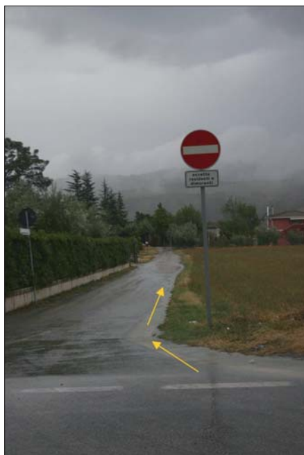
Figura 9 – Direzione dei flussi idrici sfuggiti ai sistemi di smaltimento delle acque meteoriche ed incanalate in una strada comunale che ricalca la condizione di massima pendenza.
