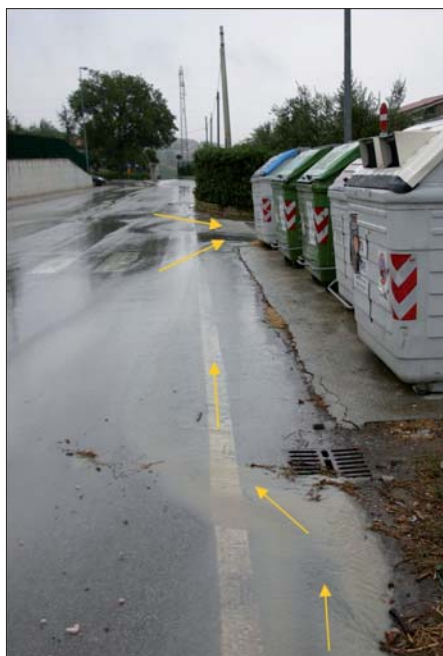
Figura 9 – Direzione dei flussi idrici sfuggiti ai sistemi di smaltimento delle acque meteoriche ed incanalate in una strada comunale che ricalca la condizione di massima pendenza.
